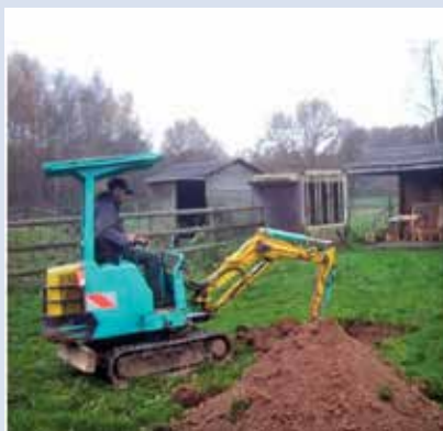
Etude du sol, pour créer une mare
