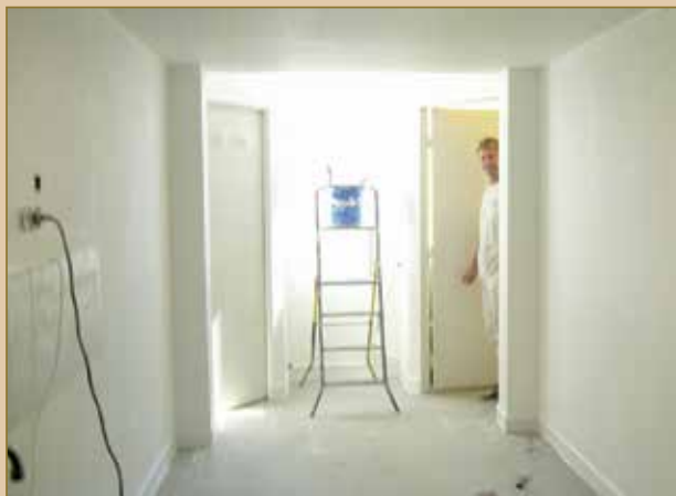
Réfection totale de la tisanerie
