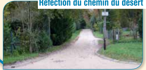
Réfection du chemin du désert
