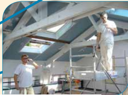
Travaux à la Mairie et à l'école
