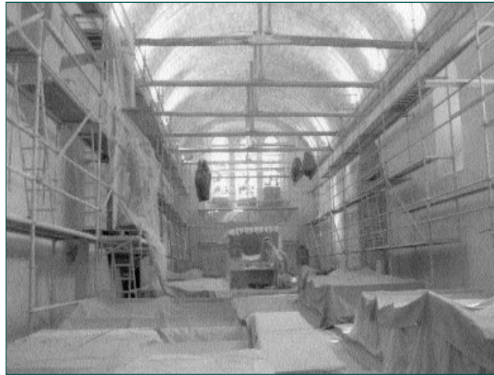
Le chantier - août 2005
