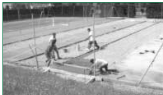
Réfection du terrain N° 2, mai 2003
